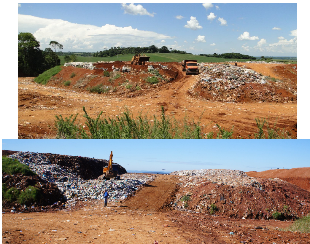
Figura 14 – Vista do aterro sanitário
