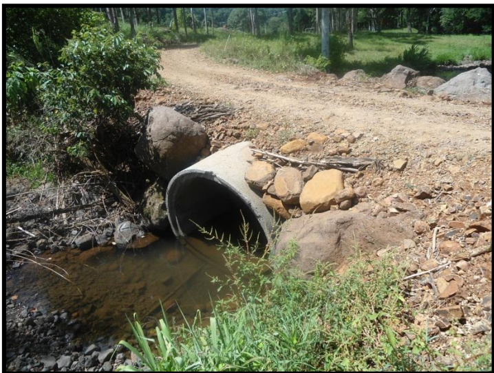
Figura 20: Bueiro localizado no acesso a comunidade Barreiro.
